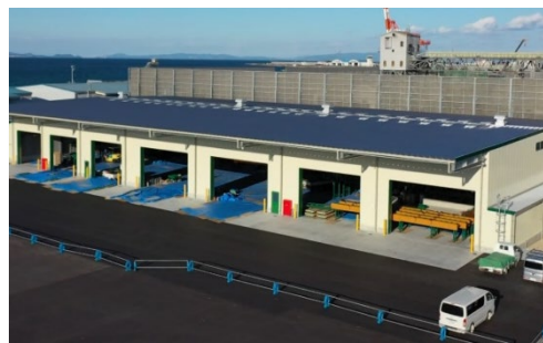
徳島製材工場の新工場着工
