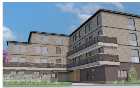
飛島建設(株)と木造専門の建設会社(株)ウッドエンジニアリングを設立
