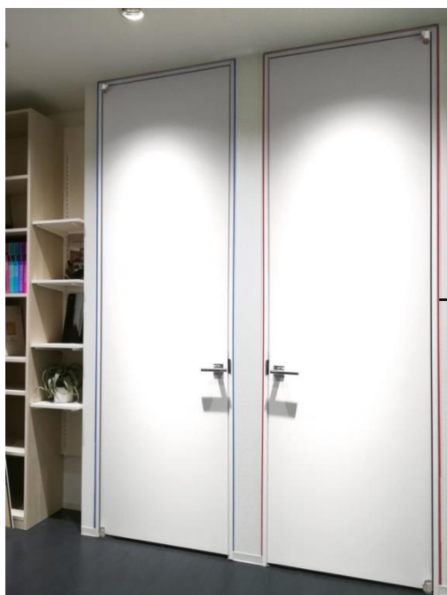
枠にカラーをつけることで室内サインの機能を持たせた「スリット枠」
