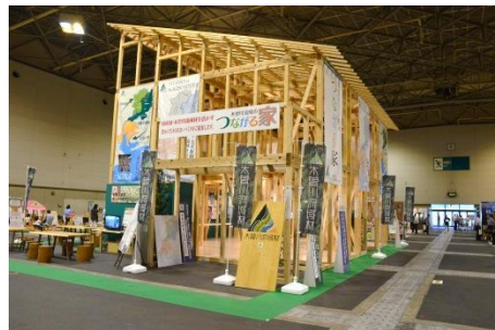
木曽川流域材をパッケージ化した 2階建ての構造躯体
